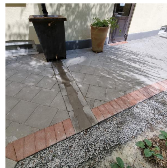
Fig. 9. En dagvattentunna samlar vattnet från ca 90 m2 takyta. Exempel från Mölllevången, Malmö.
