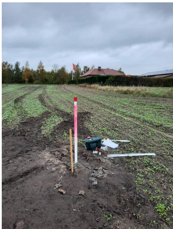
Figur 7. Installerat grundvattenrör i provpunkt 20W04. Vy mot nordost.
