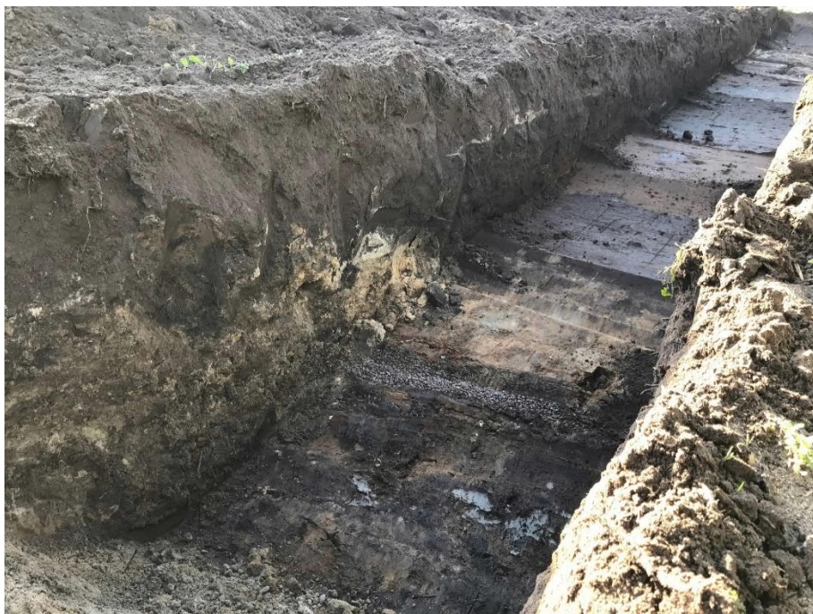
Figur 4. Schakt i jakt på dräneringsledningar i åkern inom planområdet. Aktuellt schakt upptaget väster om provpunkt 20W13. Översta lagren utgörs av mullhaltig sand vilken underlagras av naturlig sand.
