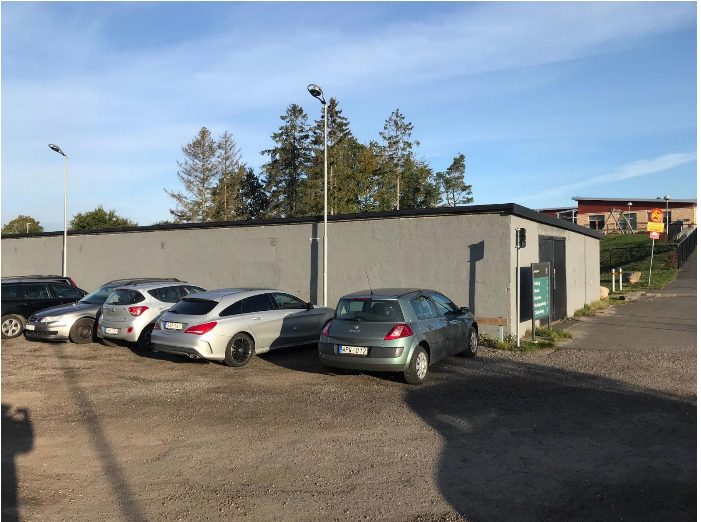
Figur 1. Parkeringsyta samt byggnad inom planområdets nordvästra del. Upp för slänten syns förskolan inom fastigheten Saxtorp 10:34, där Nilssons metallgjuteri tidigare bedrivit tungmetallgjuteri. Grundvattenrör (20W07) installerades med dexel strax utanför bild till vänster. Vy mot norr.
