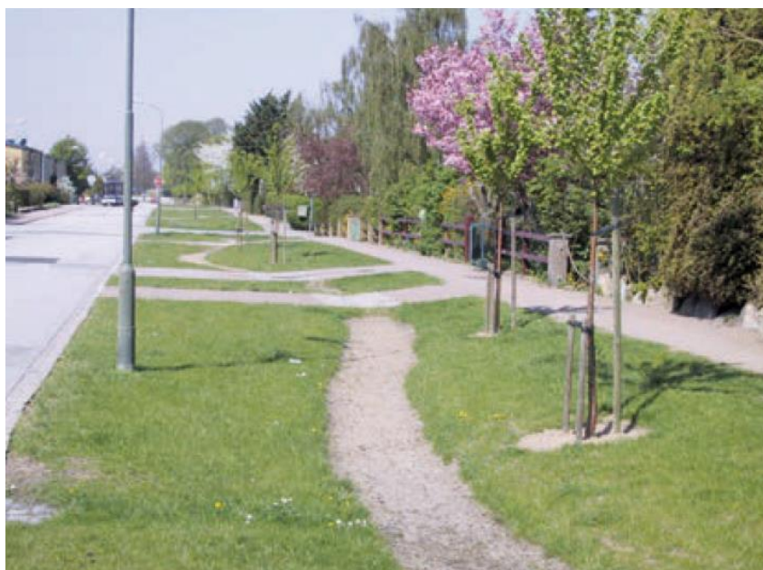
Figur 15. Svackdike vid Vanåsgatan i Malmö
