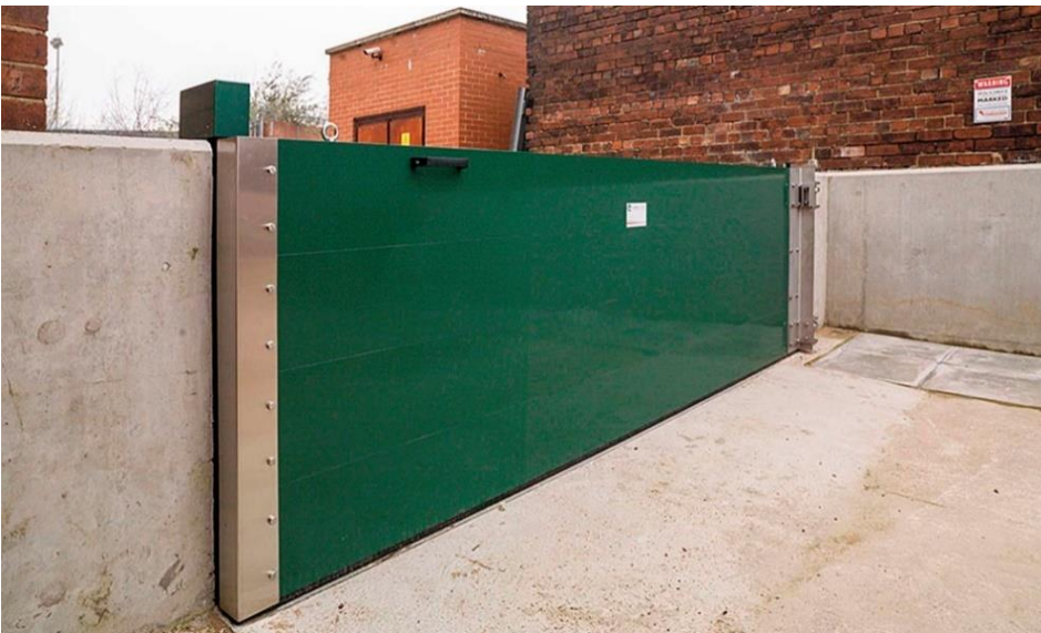
Figur 7-5 Exempel på slagport som kan stängas i samband med högvatten. Bildkälla: Flood Protection International.
