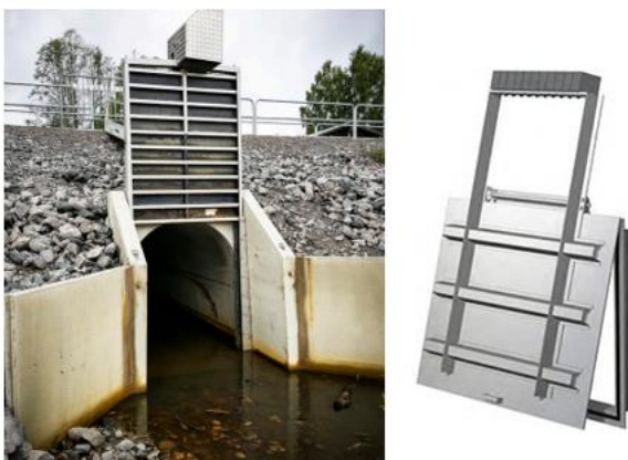
Figur 7-1 Exempel på motorstyrd bakvattenlucka (till vänster) och klafflucka (till höger).
