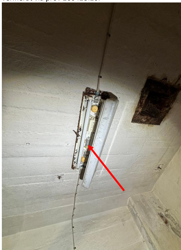
Foto 16. Småkondensatorer av metall, plast och papper av olika fabrikat (se röd pil för exempel) bedöms innehålla PCB-olja till dess att motsatsen är bevisad.
