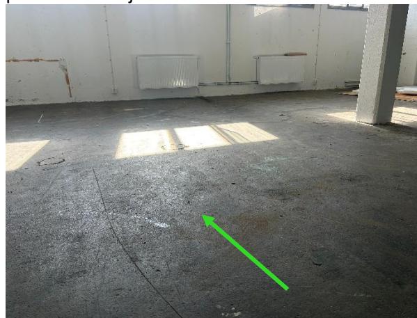
Foto 32. Svart beläggning förekommer generellt på plan 4 och 5.
