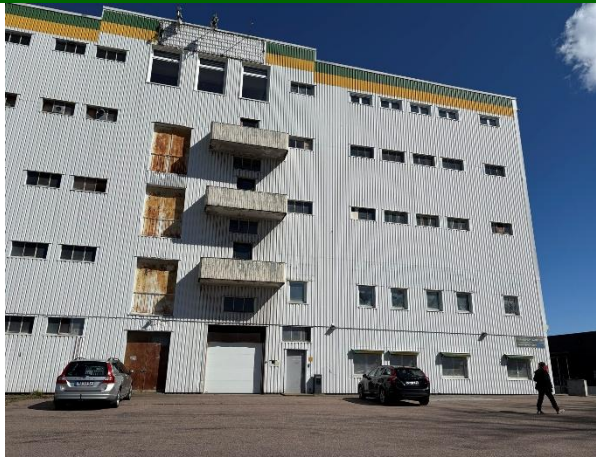
Foto 1. Översiktsbild över del av söderfasaden på den aktuella byggnaden som omfattats av undersökningen.
