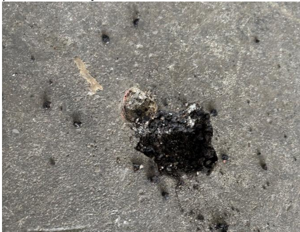
Foto 33. Närbild på svart beläggning som förekommer generellt på plan 4 och 5.
