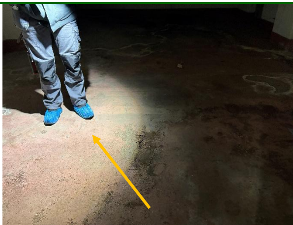
Foto 17. Röd flagnad golvfärg på källarplan (se orange pil) innehåller förhöjda halter arsenik (182 mg/kg) och PCB-7 (4,46 mg/kg), verifierat via prov 260428:29.
