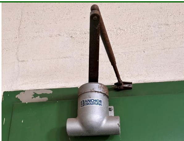
Foto 13. Dörrstängare av bland annat fabrikat Eskilstuna bedöms innehålla PCB i olja tills motsatsen bevisats.
