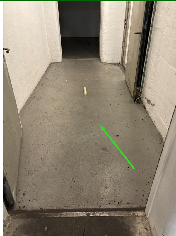
Foto 22. Grå golvfärg förekommer i två mindre utrymmen på bottenplan, se grön pil. Golvfärg innehåller ej metaller överskridande GvFA, verifierat via prov 260416:12. Innehåller ej asbest, PCA eller PCB överskridande laboratoriets rapporteringsgräns.
