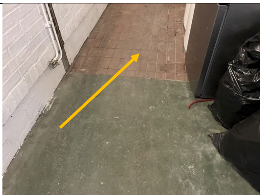
Foto.79; Äldre.klinkerfix_och.fog.(orange.pil).kan.innehålla.asbest.och.bör.provtas.inför.rivning.eller.ombyggnation;
