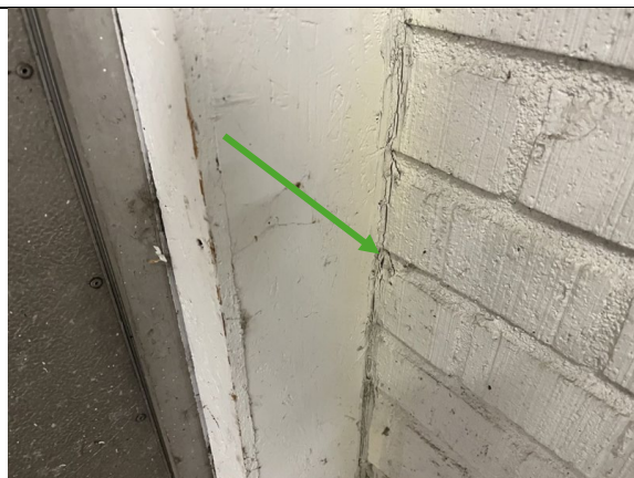
Foto.8; Vitmålad fog (grön.pil) vid invändig skarv. branddörr-tegelfasad innehåller ej asbest eller bly? klorparaffiner och PCB i halter som överskrider gränsvärden för farligt avfall? verifierat via prov. 8268808;
