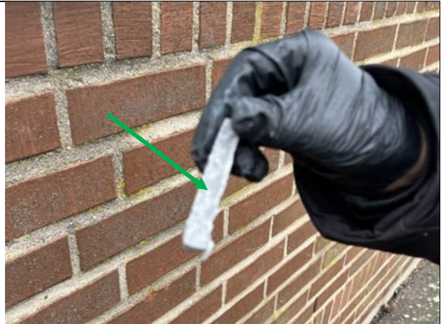
Foto.5.Dilationsfog.(grön.pil).innehåller.ej.asbest? verifierat.via.prov.8268811. Tidigare.provtagning.i. samband.med.utförd.PCB_inventering.har.ej.påvisat. förhöjd.förekomst.av.klorparaffiner.eller.PCB. överskridande.en.totalhalt.på.70ppm;
