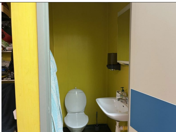
Foto.71; Gul.våtrumstapet.kan.ex; innehålla.asbest?klorparaffiner?bly.och.ftalater.och.bör.provtas.inför.rivning.eller.ombyggnation;
