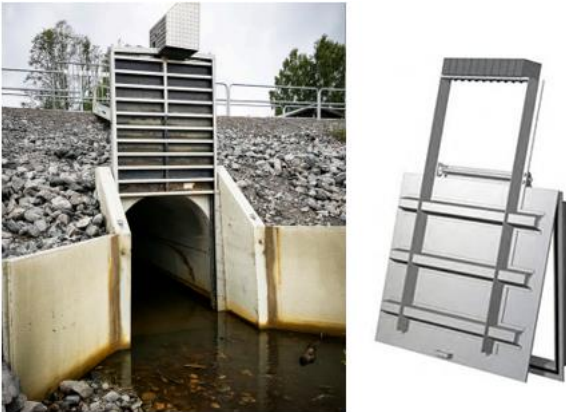
Figur 7-2. Exempel på motorstyrd bakvattenlucka (till vänster) och klafflucka (till höger).
