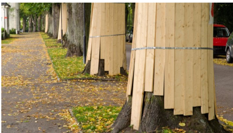
Figur 3. Exempel på brädning av träd inför byggnation. [Bild från Byggekoll.se]
