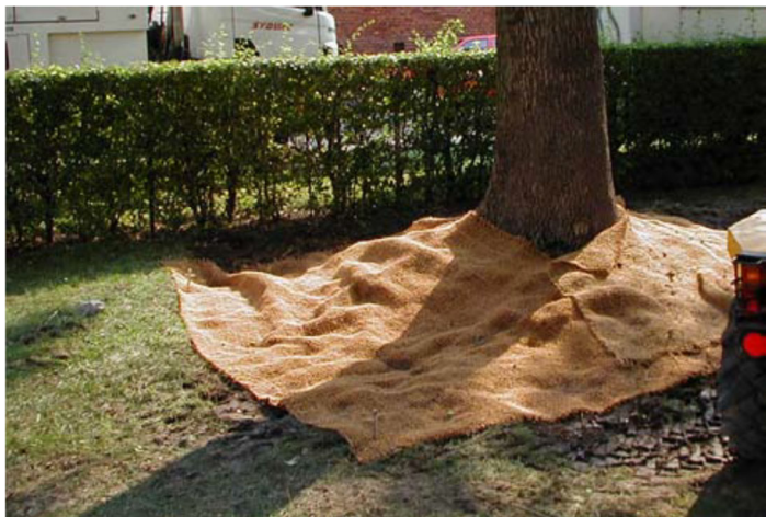
Figur 2. Exempel på skydd av frilagda rötter med kokosväv. [Bild från Teknisk handbok Norrköping]
