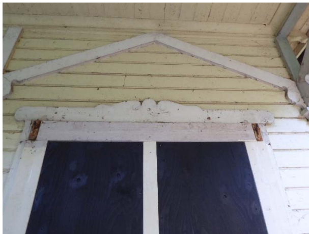
Snidade konsoler på verandan och bearbetade överstycken och dekorationer på entréfasaden.
