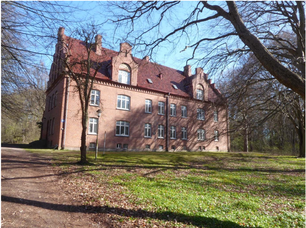
Södra fasaden tjänstemannabostaden.
