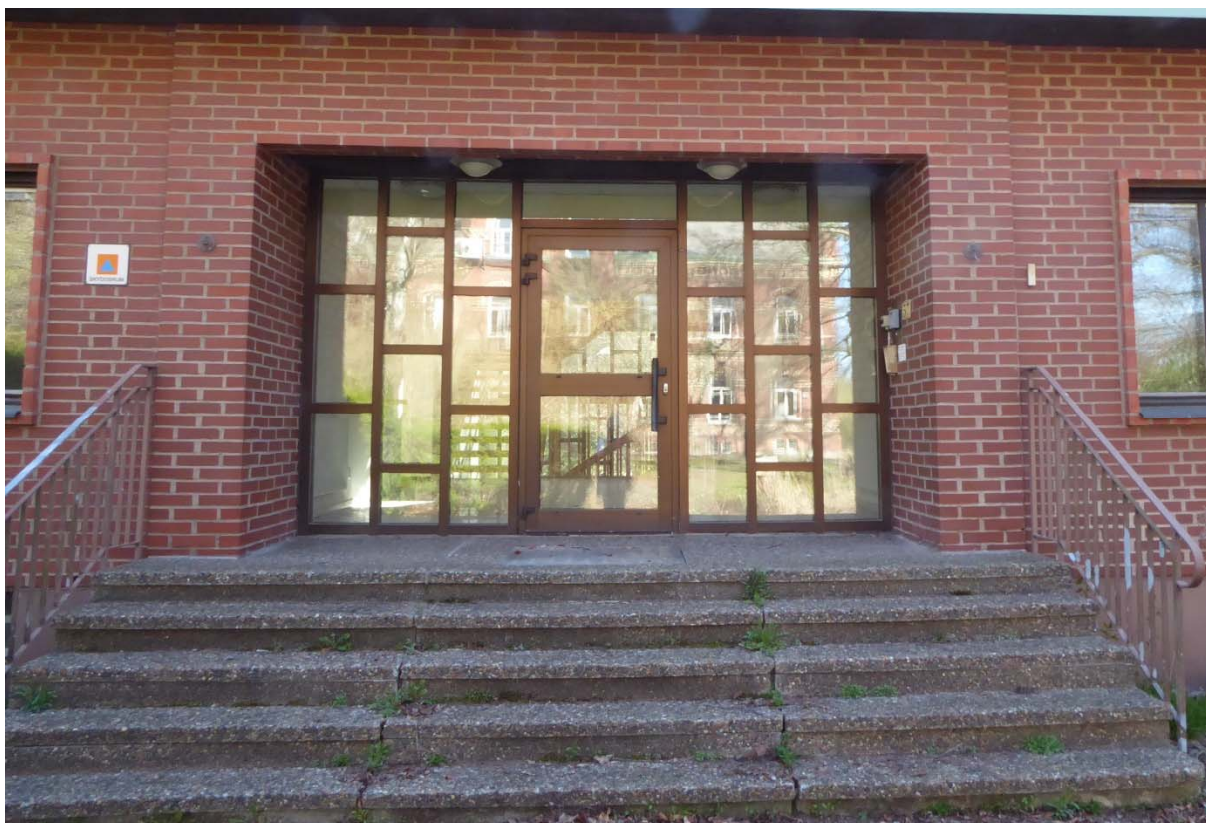
Entréparti västra fasaden.
