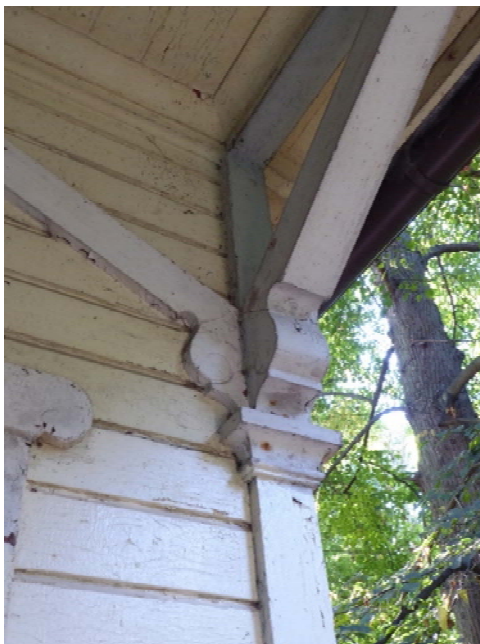
Snidade konsoler på verandan och bearbetade överstycken och dekorationer på entréfasaden.
