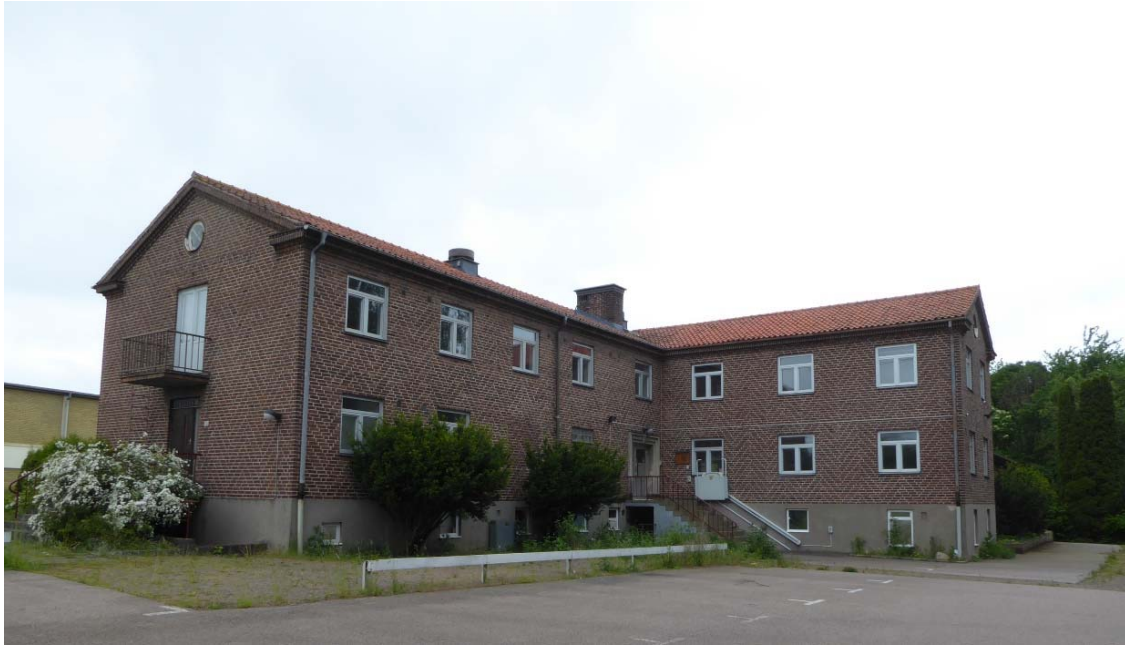
Personalmatsalens norra och östra fasader.
