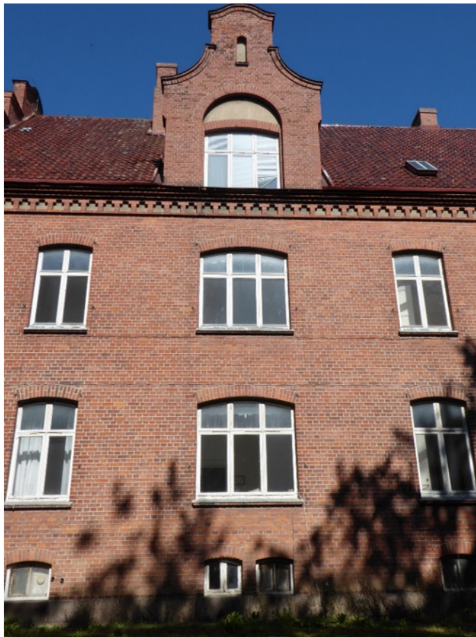
Fasadparti där fönstren i frontespisen och fasaden har samma indelning.
