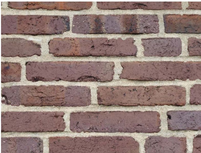
Hårdbränt brunrött tegel från Helsingborgs Ångtegelbruk.
