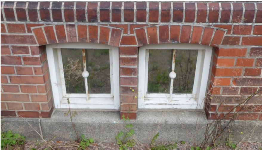
Källarfönster med vertikalt vitmålat järn.
