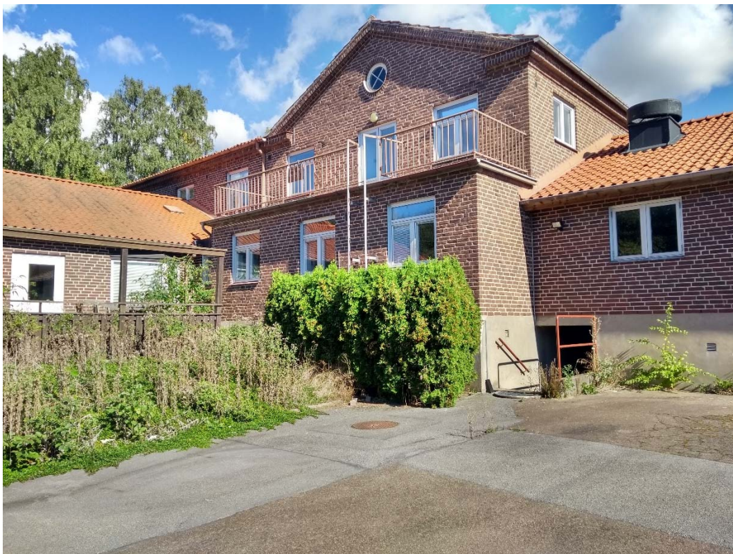
Västra fasaden med tillbyggnader mot söder och väster.
