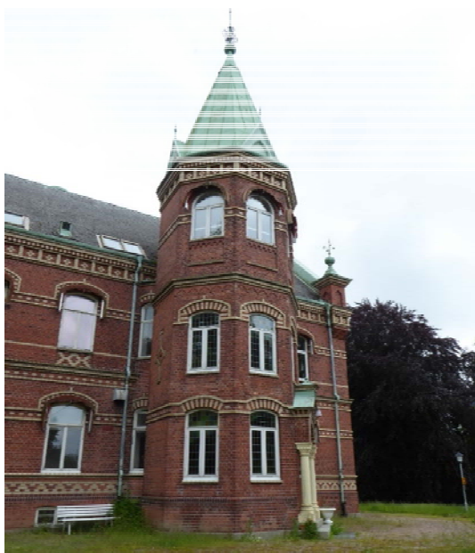
Trapphuset asymmetriskt placerat på den västra gaveln.
