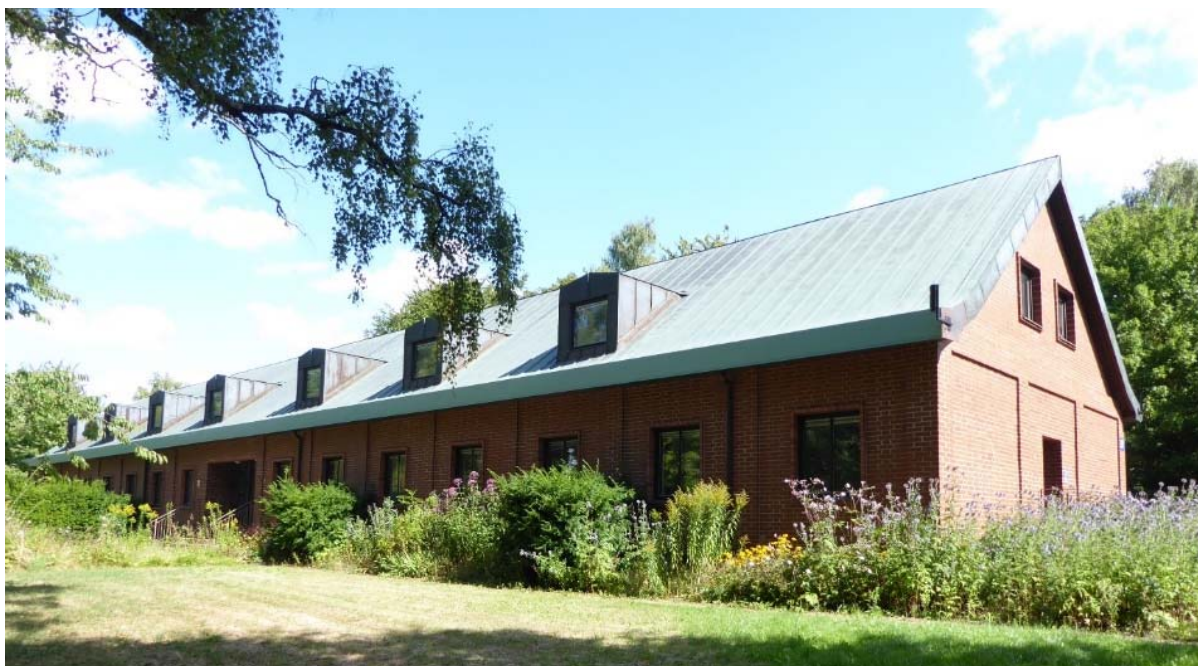
Byggnadens västra fasad.
