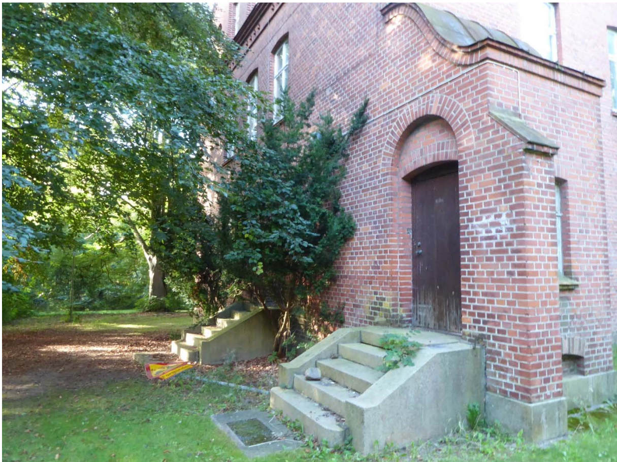
Entréparti vid det nordöstra hörnet. De två fritrapporna i granit, östra gaveln.
