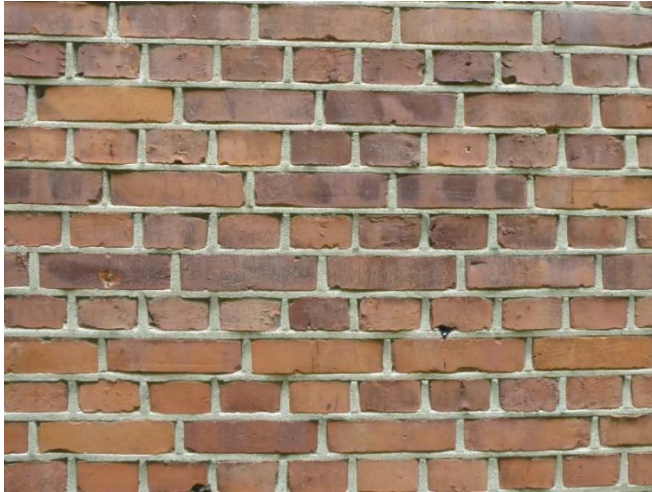
Tegelfasaden har en bred, lätt konvex fog.
