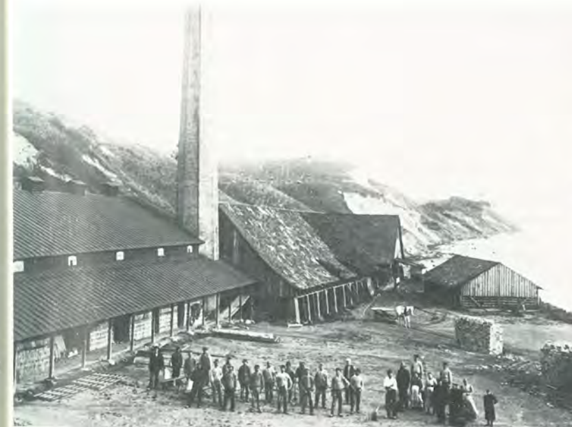
Hildesborgs tegelbruk - ett av de många tegelbruken norr om Landskrona.
