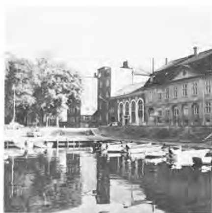
Kv Gamla Bryggan
