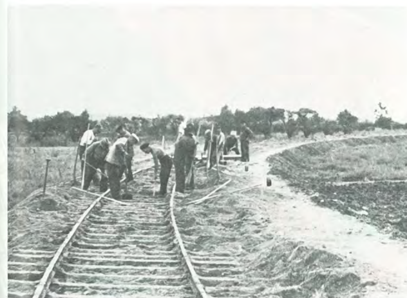
Rälsdragning på Öresunds- varvet. Nödhjälpssarbete 1935-1937. L.M.B.
