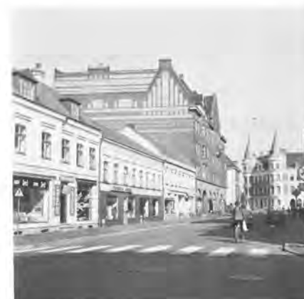
Kv Västra Roten
