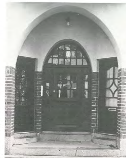
Att bevara entrépartierna i hyreshusen är viktigt för såväl huset som för gatumiljön. Här ses entrén till bosthuset vid Skollallen/Regeringsgatan, ritad av Frans Ekelund.
