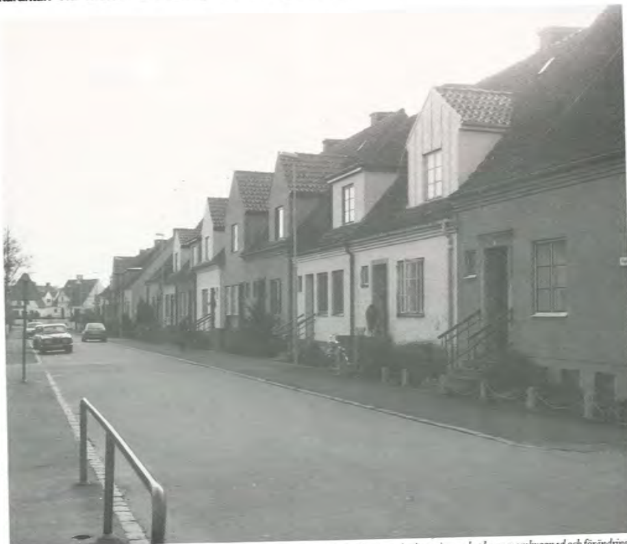
Radhus vid Norrevärmsplan. Alla hus är beroende av varandras utseende. Tänk därför på omgivningen innan du planerar ombyggnad och förändring.
