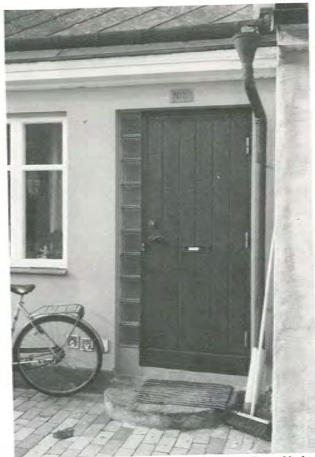
En ny dörr kan innebära stora kulturhistoriska förluster för ett äldre hus. Här ett exempel med passarglas från slutet av 1960-talet.
