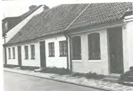
Det karakteristiska med husen i kvarnorgsområdet är att de är ganska likartat uppförda. På bilden ses tre hus av denna typ. De större har dörren placerad centralt med två fönster på ömse sidor. De mindre husen har bara "halva" fasader, dörren sitter i ena sidan av huset.
