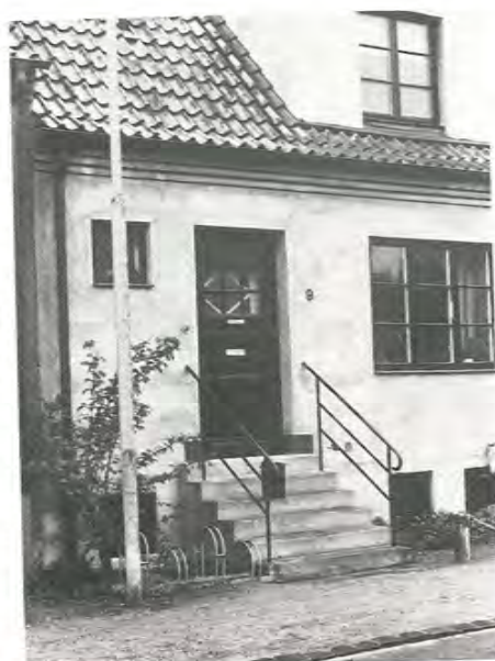
Ett väl bibehållet entreparti. Lägga märke till trapppricke, dörr och fönster som är "försett med rotnes spröjs".
