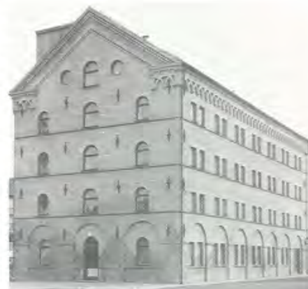
Hellbergska spannmålsmagasinet som byggdes på 1870-talet är en synnerligen god exponent för 1800-talets industribyggnad. Stor vikt lades vid utformningen.
