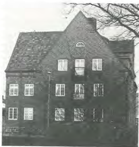
Hornhuset Harjagersgatan/Föreningsgatan invid St. Olovs sjö är ett mycket välbevarat och fint exempel på 20-talets tegelarkitektur. Huset ligger på gamla Bryggeriet Stjernans plats.
