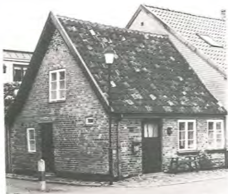
De äldsta husen byggdes med golvet direkt på marken. Husen tillhör den minsta huskategorin i Borstahusen. Typ 1.
