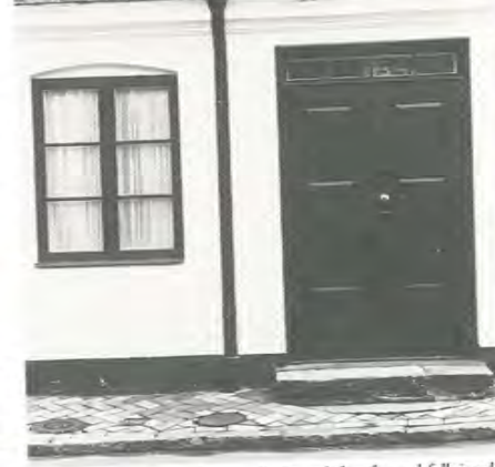
Dörrparti av traditionellt utseende. En enkelt utformad fyllningsdörr med lågt ljusinsläpp i överkanten. Snickerierna är målade med täckande oljefärg i diskret mörk nyans. I de mindre husen var dörren ofta av enklare utförande, typ plankdörr.
