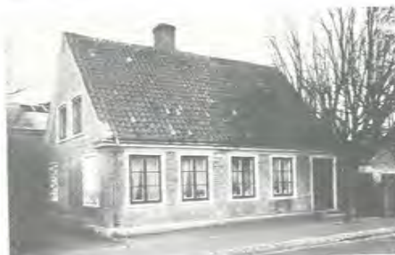
Hus av typ 2 med fönsteromfattningar i puts och avsatt grund.
