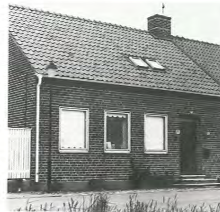
Fönster av den här typen innebär en stor fara för Borstahusens framtid.
