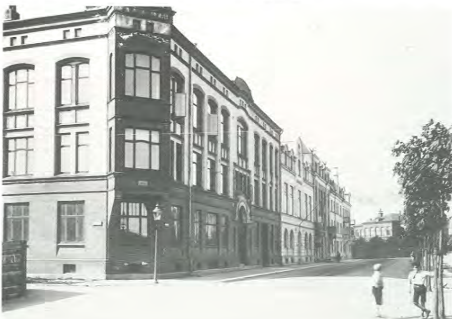
Kv. Neptun var det kvarter som först bebyggdes vid Ödmanssonsgatan. Här ses hus från 1900-talets början. Huset i förgrunden var Schläsbergs första industribyggnad.
